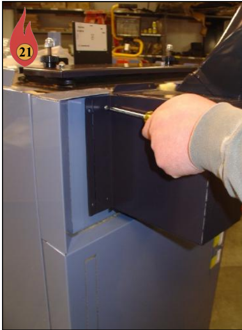
Install Fan Insulation Box
